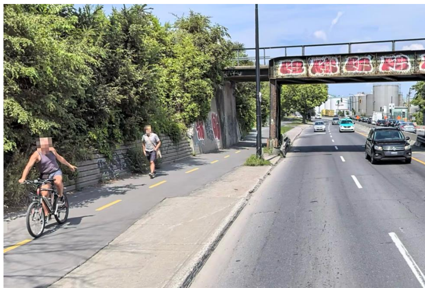
Figure 5 Passage sous la voie ferrée desservant l'ancienne aciérie
