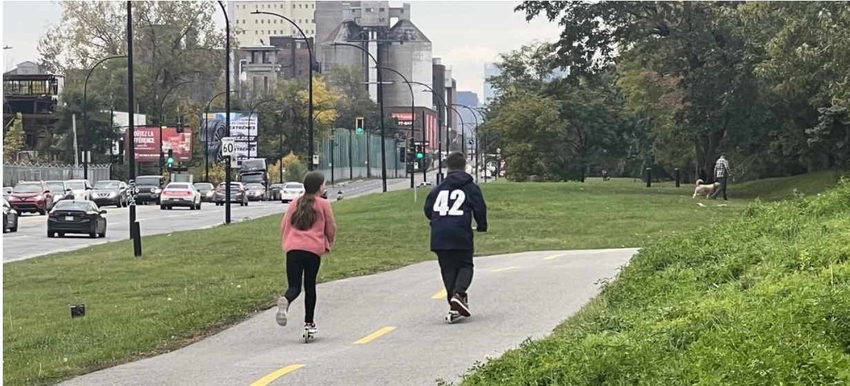
Figure 1 La largeur de 3,0 m est minimale pour une piste à deux sens de circulation Photo Vélo Québec
