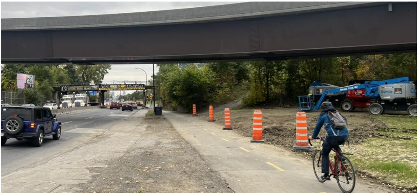
Figure 12 Voie d'accès au Port de Montréal
